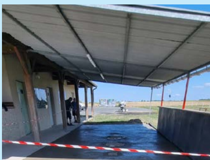
Le 2 août, création d'un espace couvert au stade de foot.
